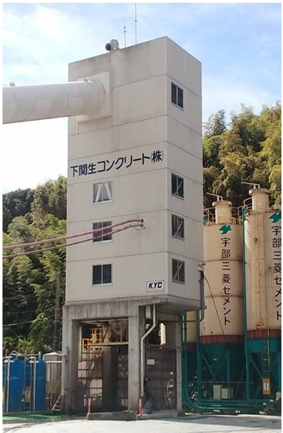
下関生コンクリートプラント
